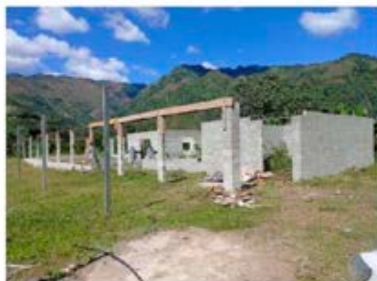
Infraestructuras para la instalación de producción piloto de abono orgánico de lombriz en fase de construcción
